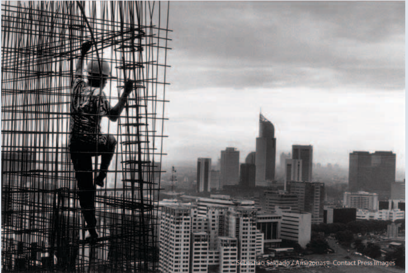
Trabajador en una obra en construcción en Yakarta, Indonesia
